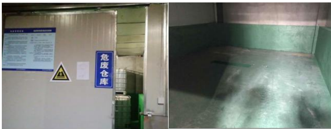
图 4-1 固废暂存场所建设情况
