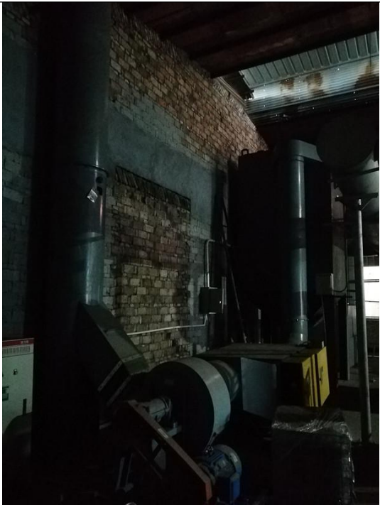
废气处理设施
