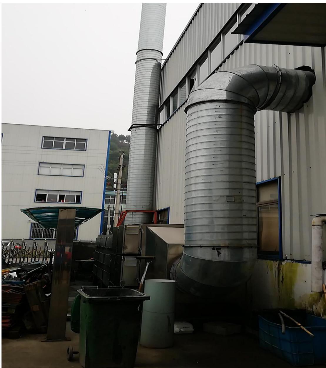
图 4-2 开炼、硫化废气处理设施图
