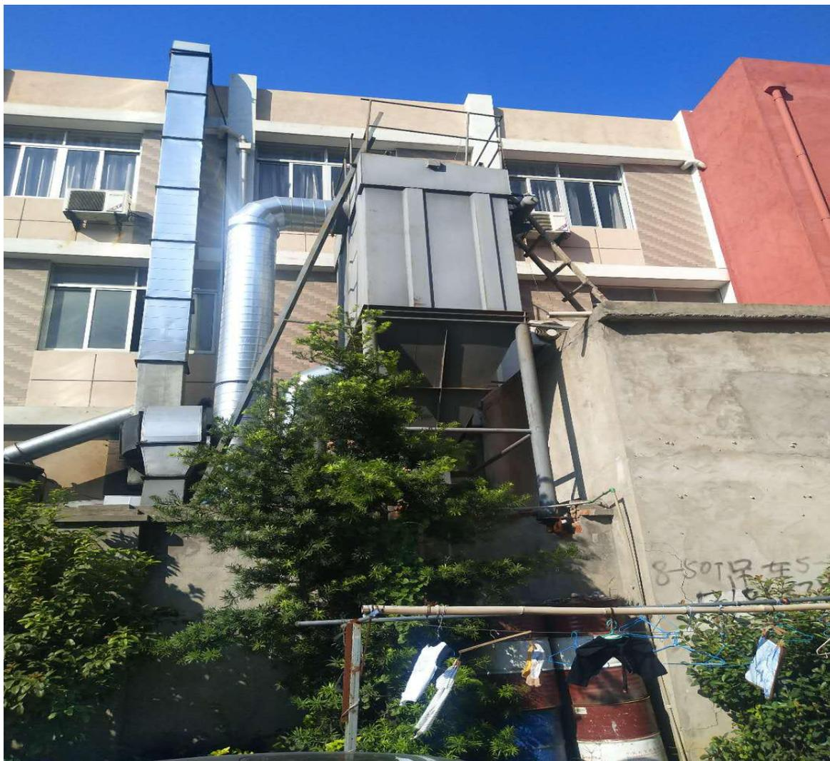
图 3-5 锌压铸粉尘处理设施图
