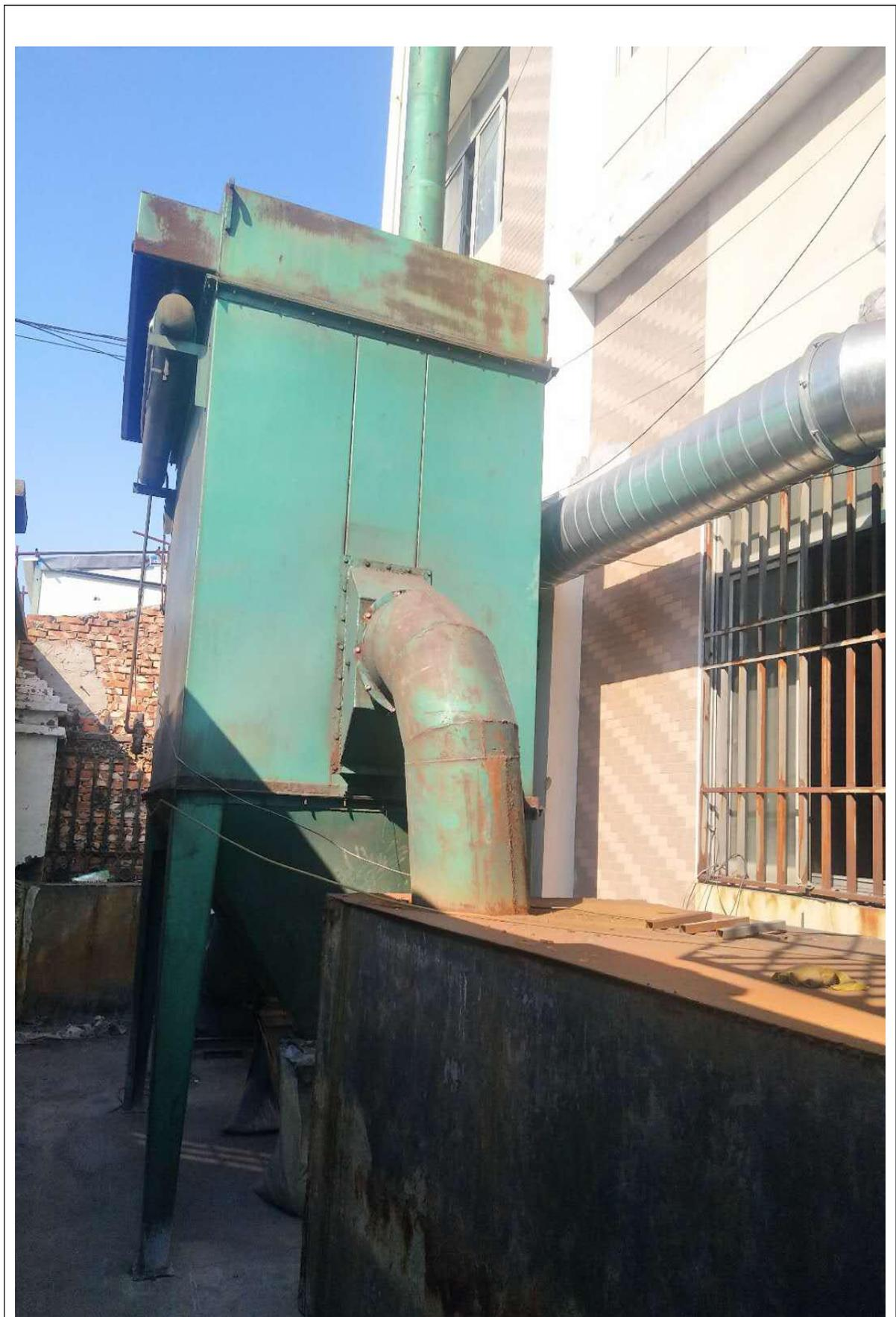
图 3-3 铜熔化废气、铜浇铸废气处理设施图
