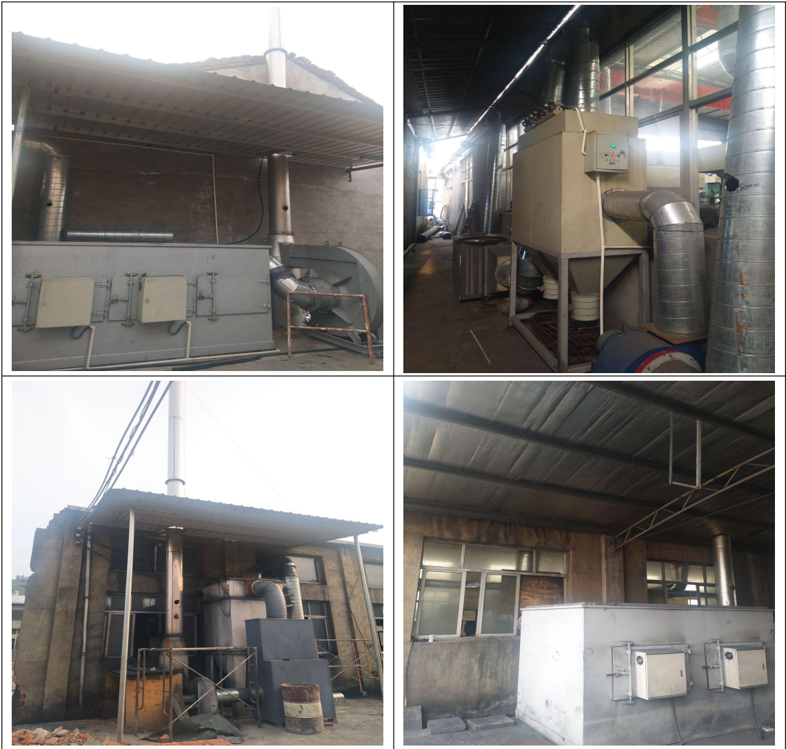
图 4-6 废气处理设施图
