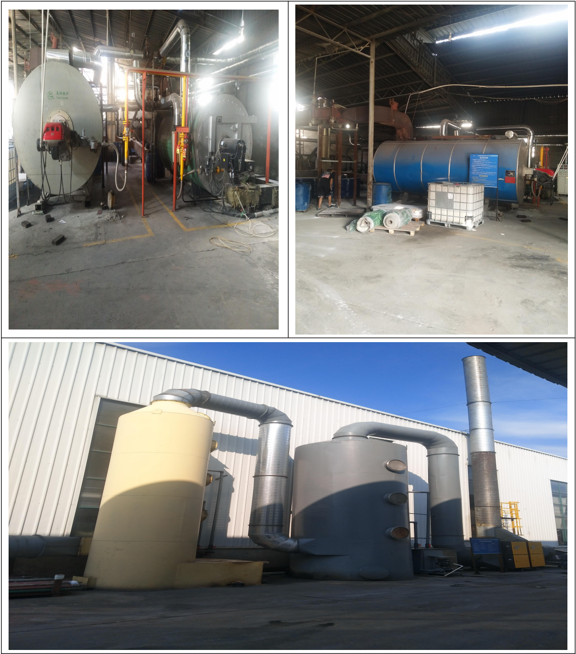
图4-5烘干定型废气处理设施图
