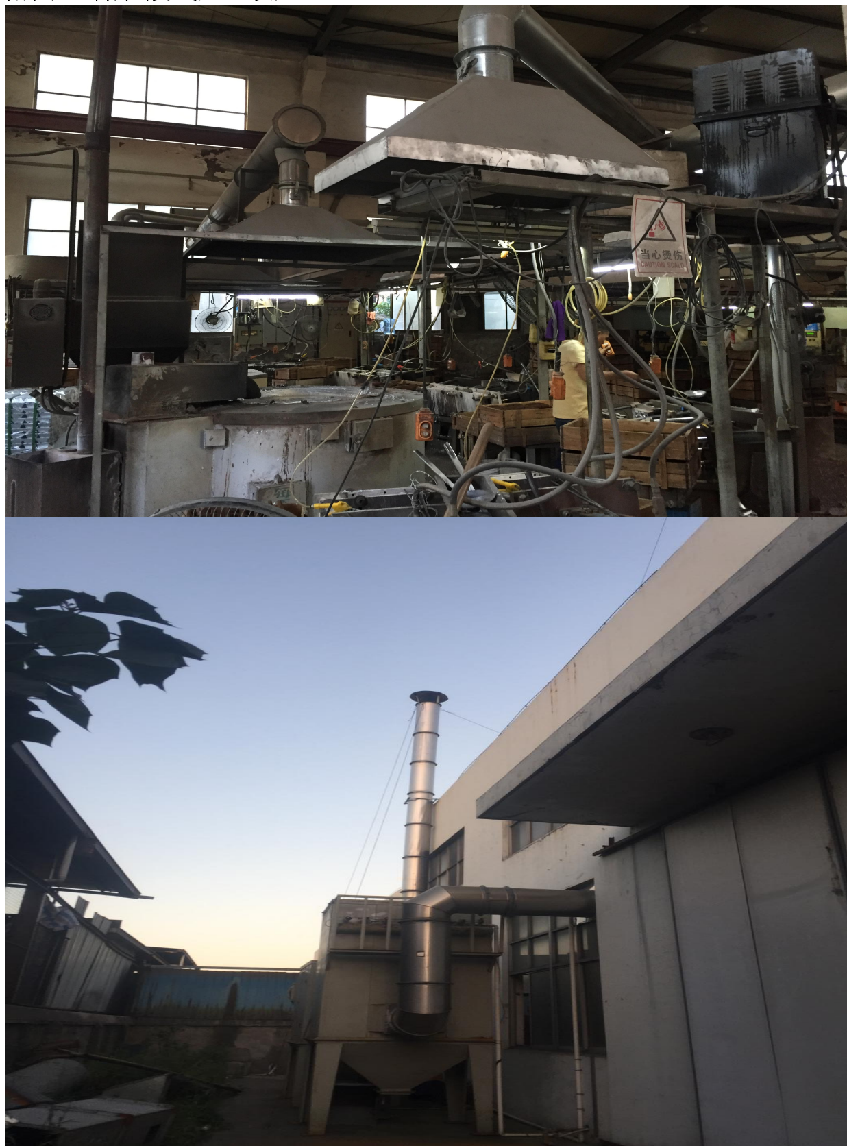
附图5 熔化废气处理设施
