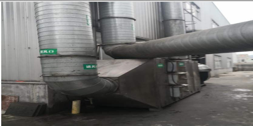
挤出、硫化废气处理设施（低温等离子）
