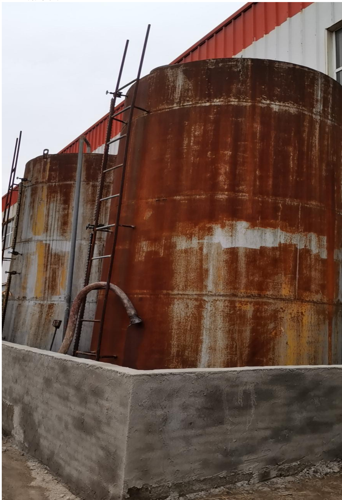
附图 7 储罐围堰
