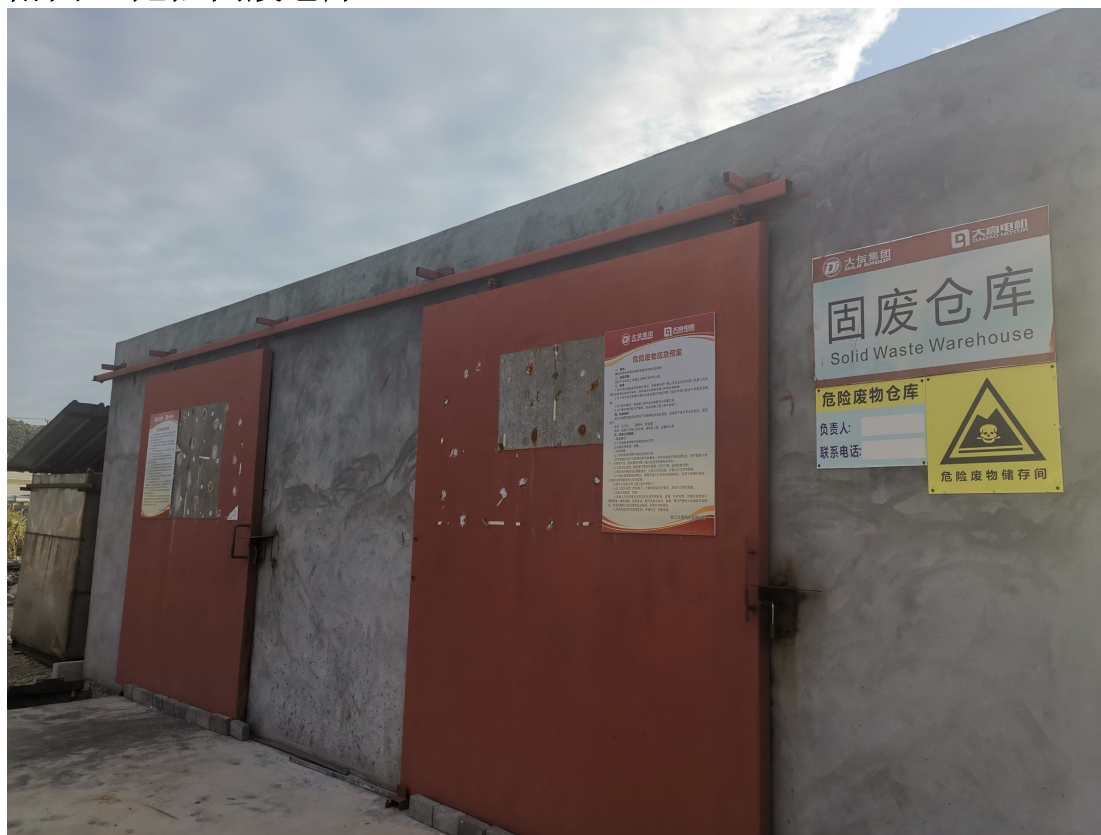
附图 4 危险固废仓库
