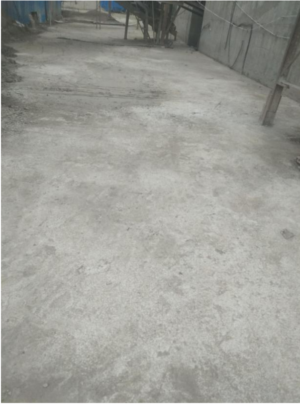
附图7 厂区地面硬化
