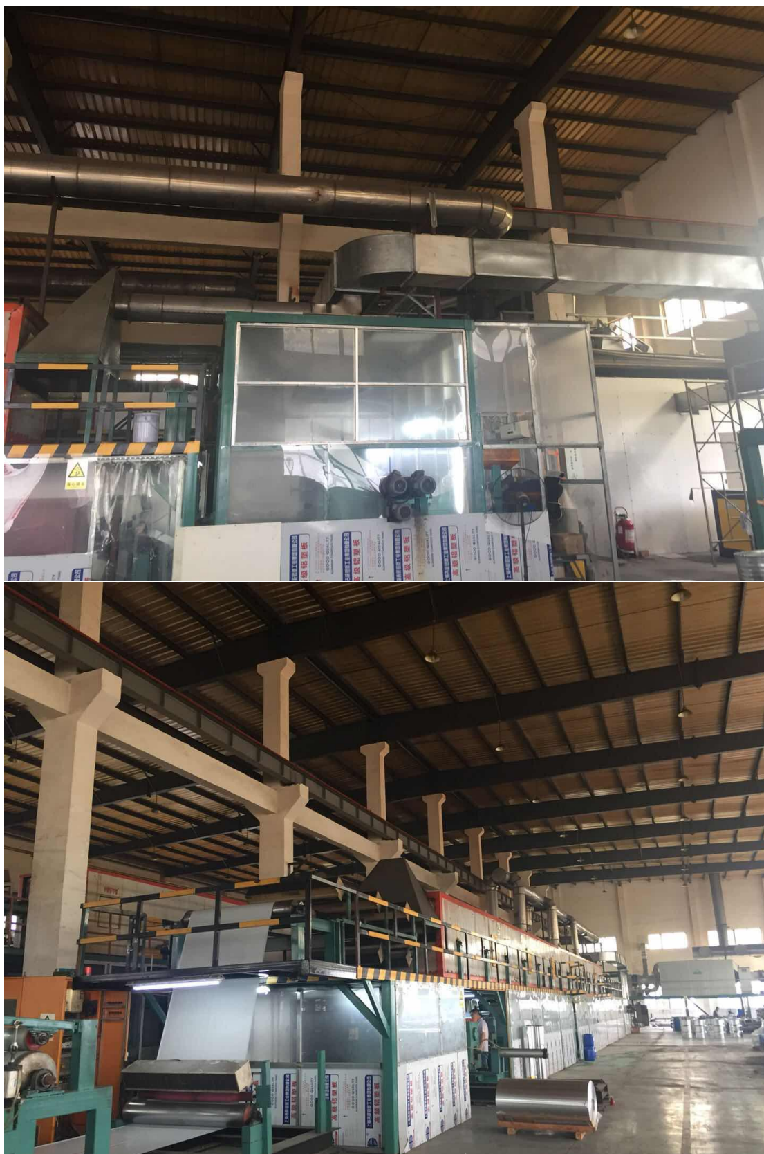
附图9 2#涂覆、固化处理设施（1#涂覆生产线）
