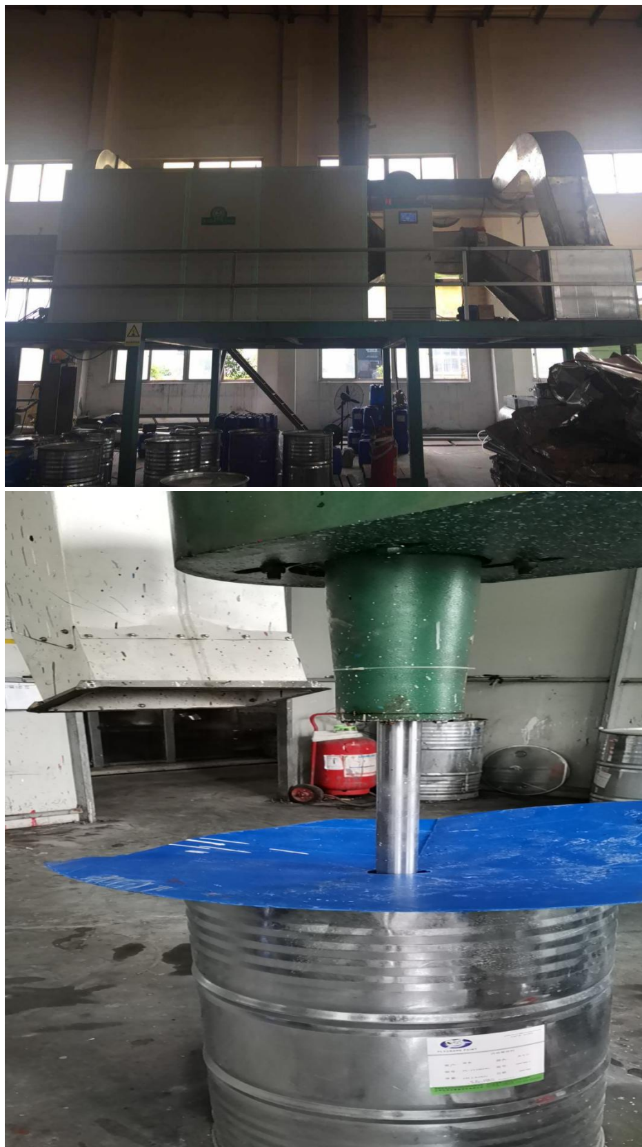
附图8 1#调漆废气处理设施
