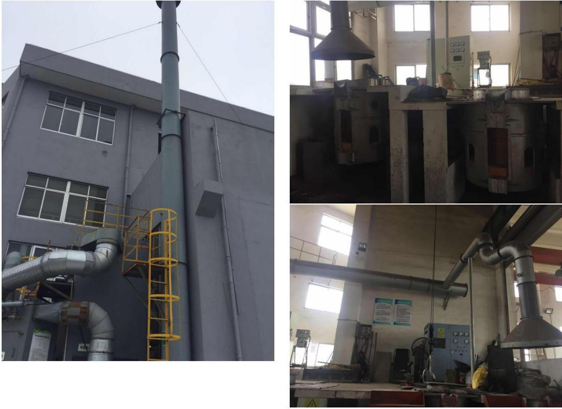
附图4 喷漆废气处理设施
