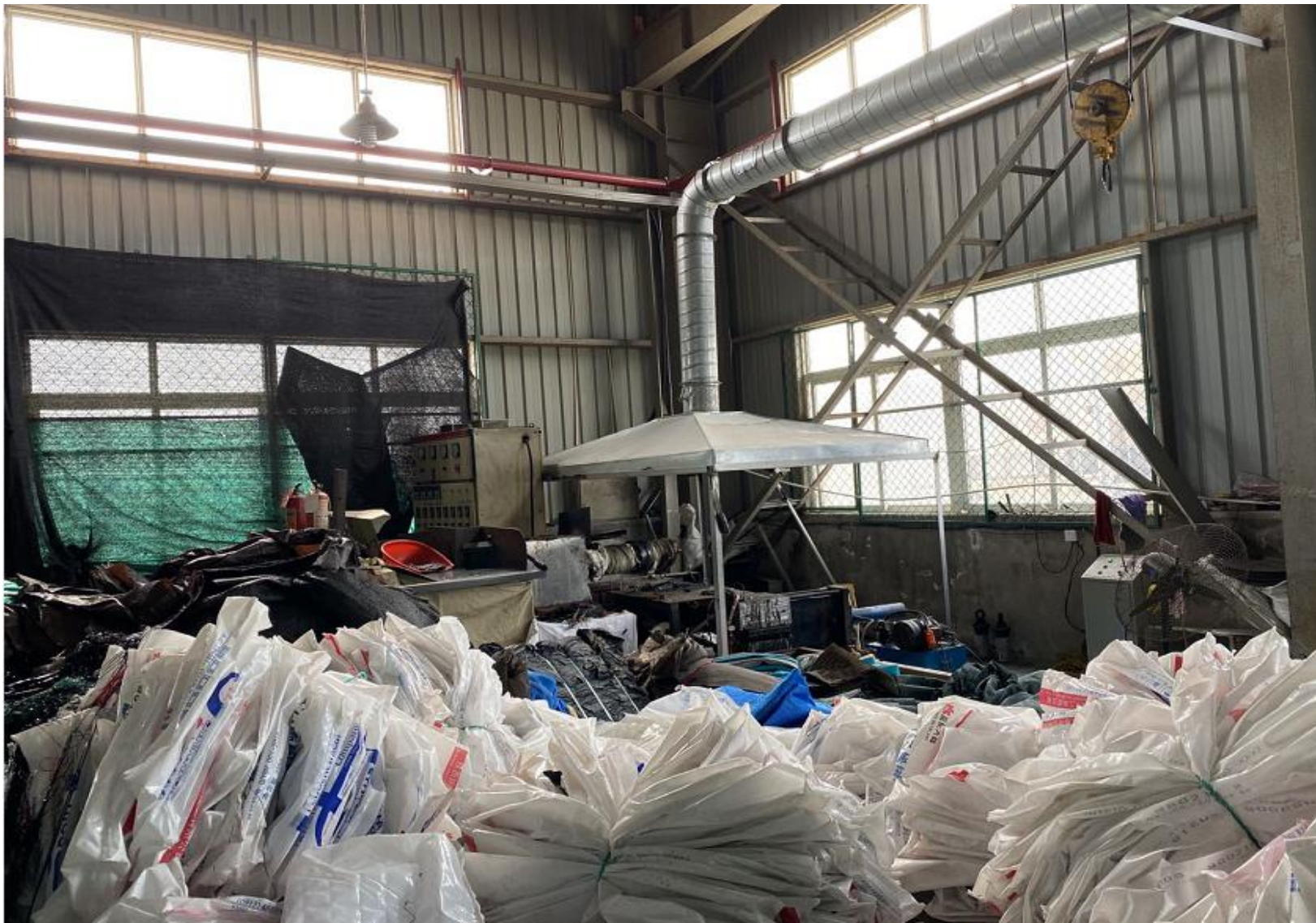
附图 4 挤出废气处理设施照片
