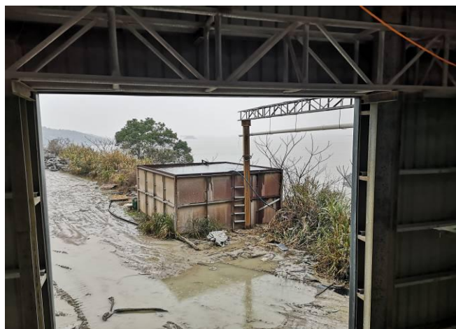
矿区中间沉淀池
