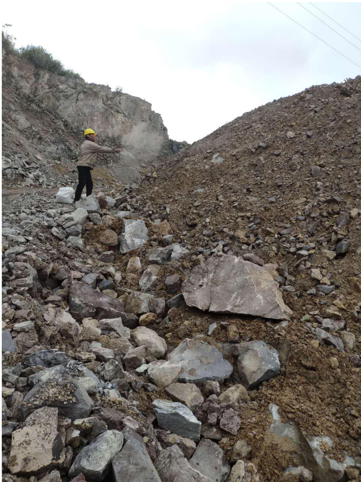
临时堆场播草籽
