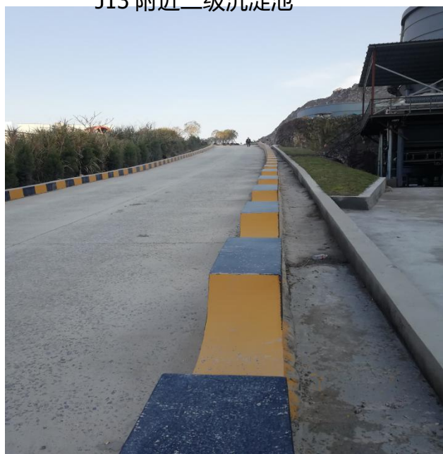
进场道路（配截水沟）
