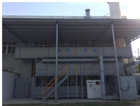
喷漆、打磨排气筒
