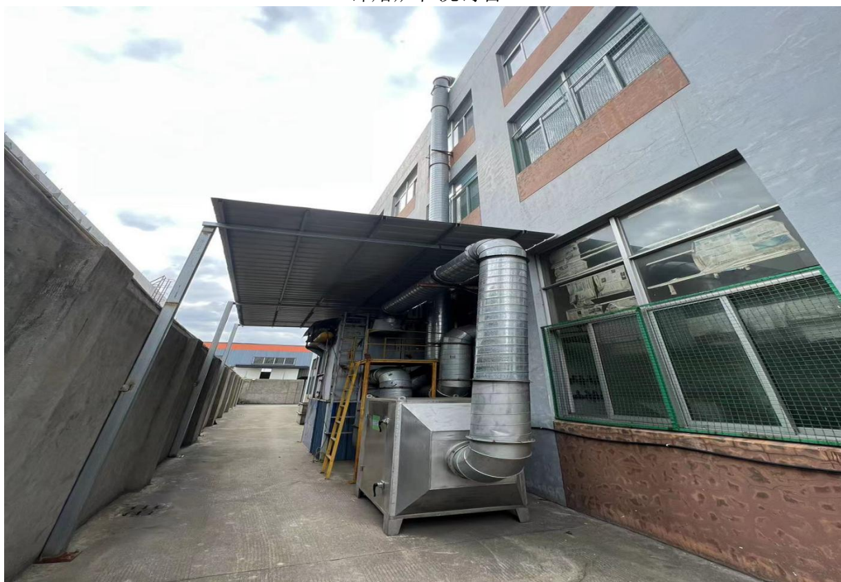
锌熔化浇铸、落砂废气处理设施
