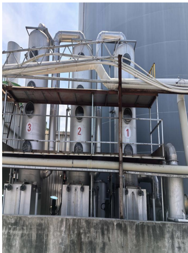
DMF 回收塔、污水站废气处理设施
