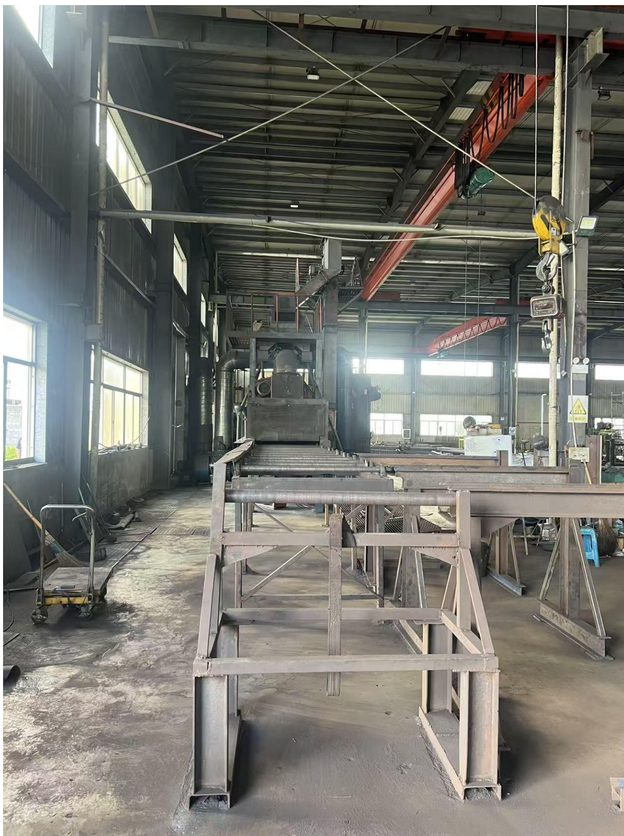
抛丸废气处理设施
