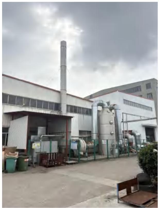
储气罐喷漆废气排放口
