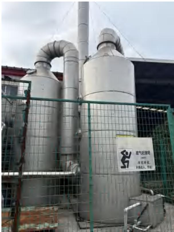
电机喷漆废气排放口
