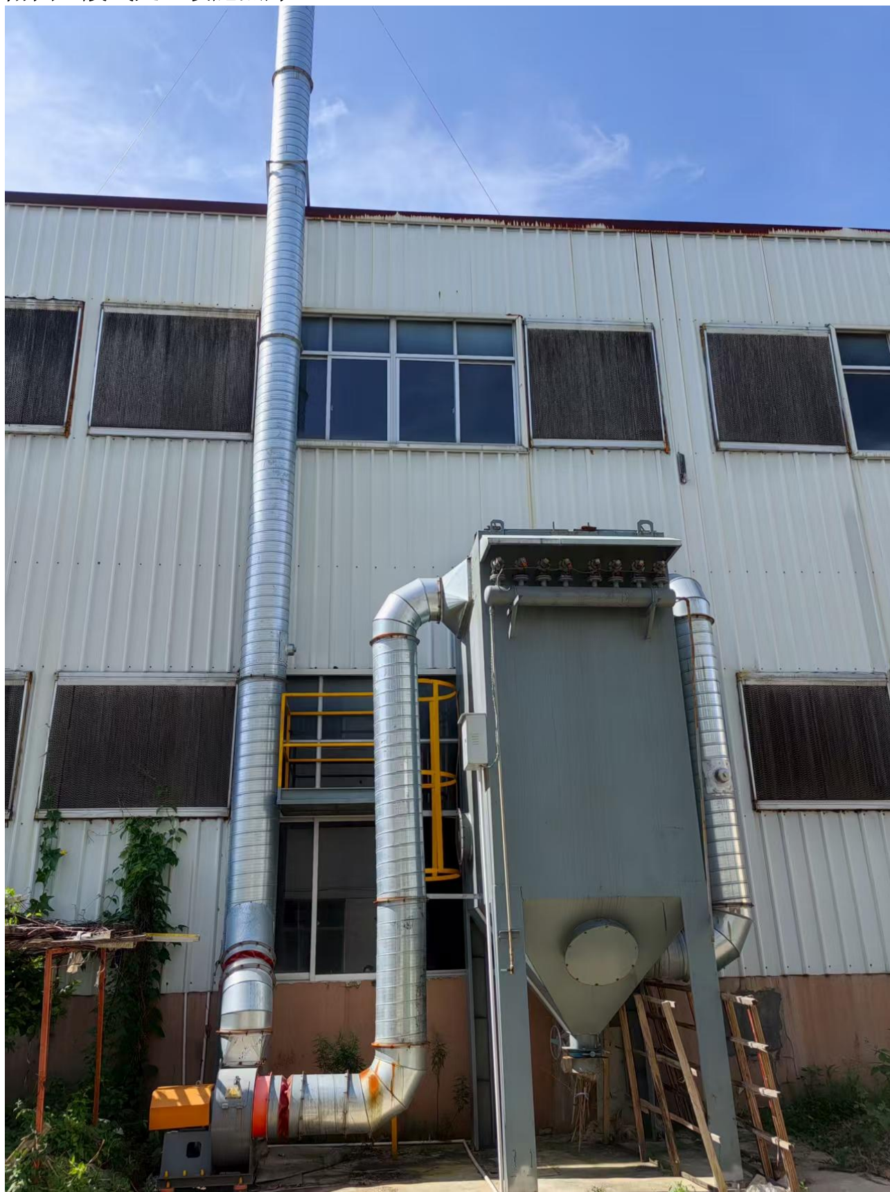
附图3 废气处理设施照片
