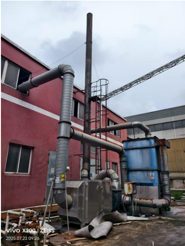
开炼、硫化发泡、密炼废气排放口
