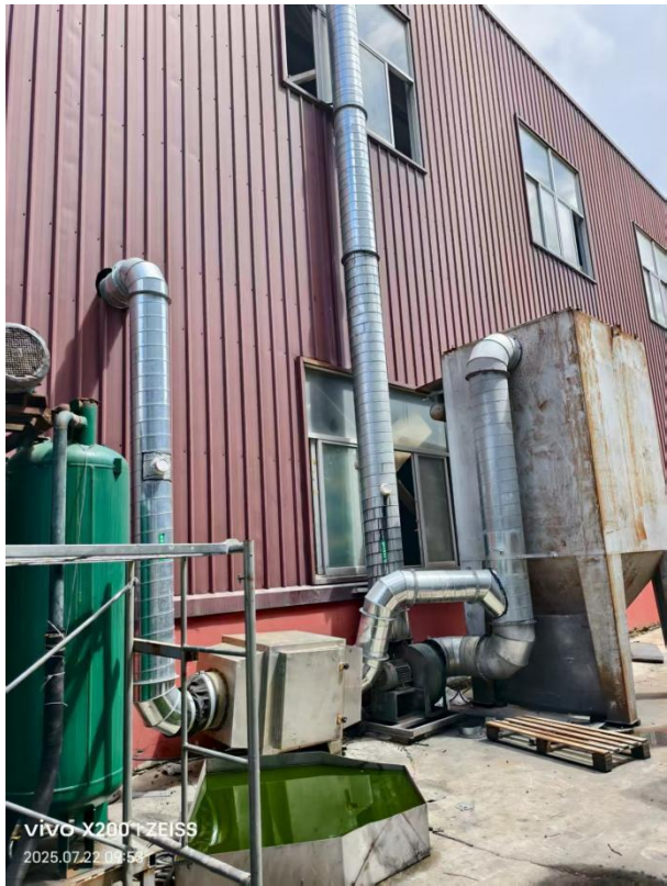
配料投料粉尘、挤出造粒废气排放口
